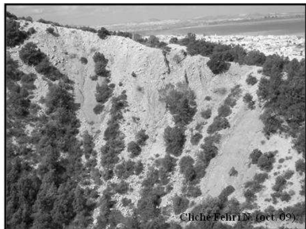
Photo 7. Etat de la couverture végétale sur un versant adret et en pente raide (versant de la montagne à la hauteur de Hammam-Chatt) (cliché N. FEHRI, Octobre 2009)
