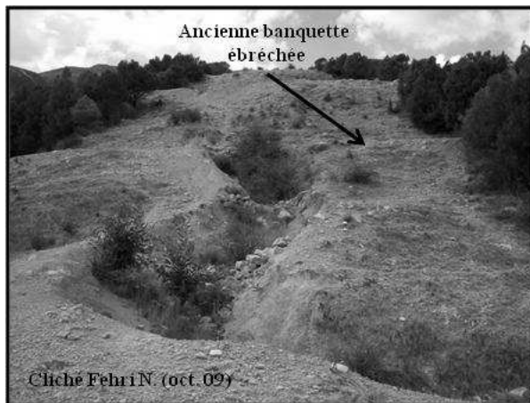
Photo 6. Ravin formé parallèlement à une bande aménagée en pare-feu (versant de la montagne à la hauteur de Hammam-Chatt) (cliché N. FEHRI, Octobre 2009)
